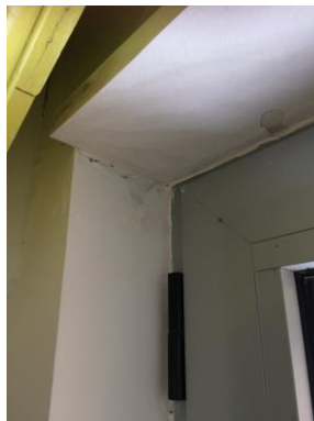
Infiltrations d'eau pluviales plafonnières et murales, boiseries gonflées d'eau
