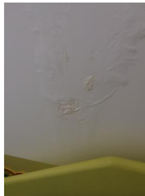
Infiltrations d'eau pluviales plafonnières et murales, boiseries gonflées d'eau
