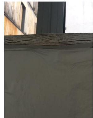
Infiltrations d'eau pluviales plafonnières et murales, boiseries gonflées d'eau
